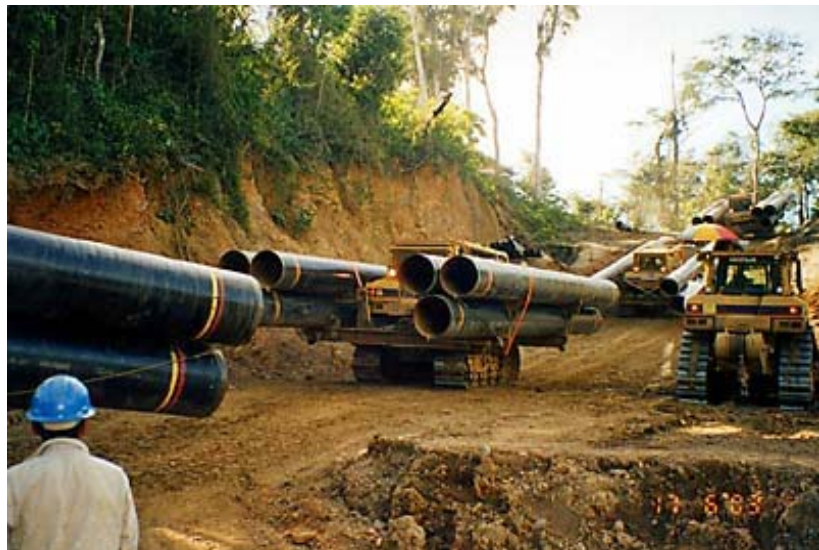
Instalación del Gasoducto del Proyecto Camisea
